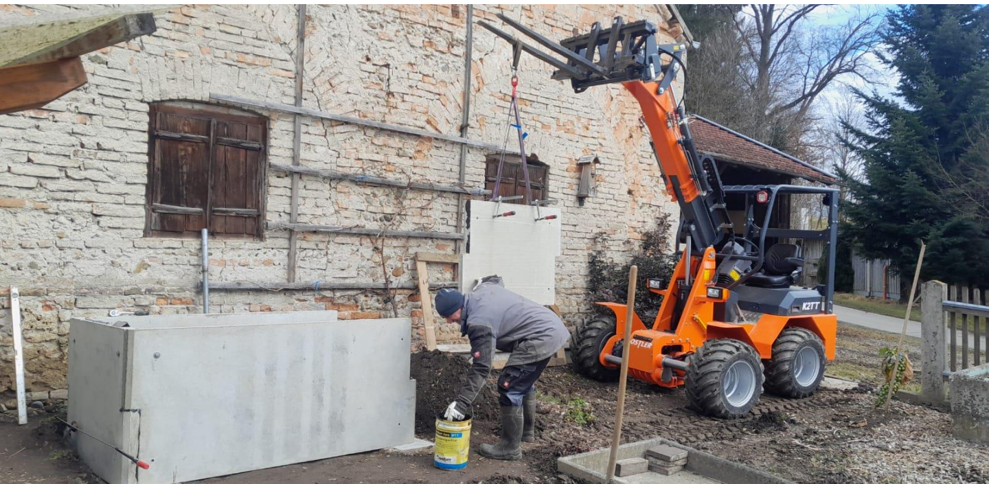
K2 TT mit Palettengabel bei Bauarbeiten
